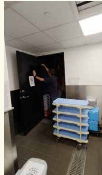
► 檢查專櫃廚房防火門
