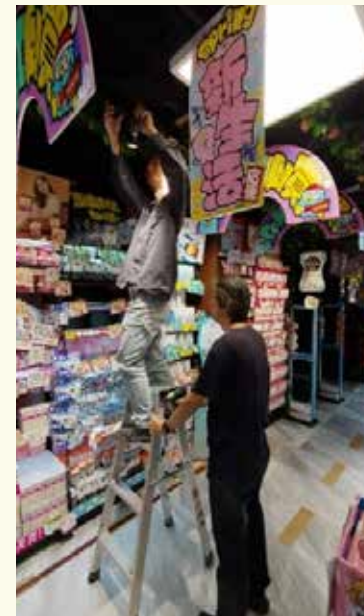
► 檢查照明電源是否正常
