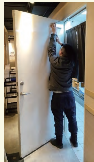
► 檢查專櫃廚房防火門
